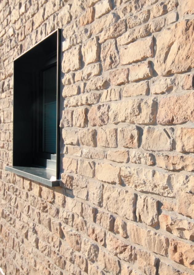
EASY-WALL est un système de parement préfabriqué en usine, composé d'une couche de plaquettes de béton serties dans un panneau de mousse polyuréthane (PUR).
